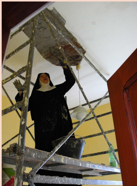
Travaux de restauration des plafonds
